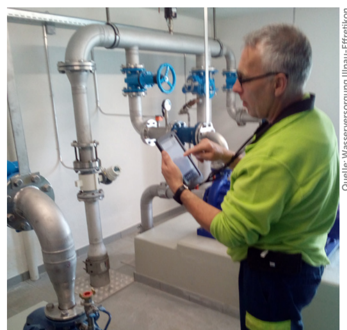
Inspektion einer Pumpstation
